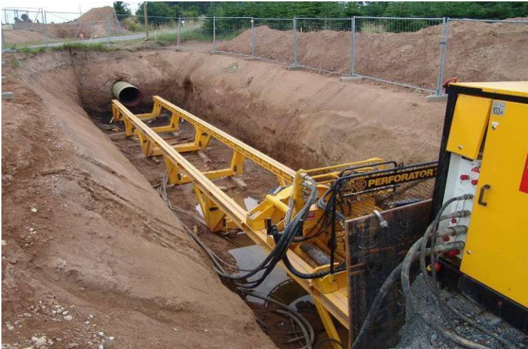
Tecnologia no dig
