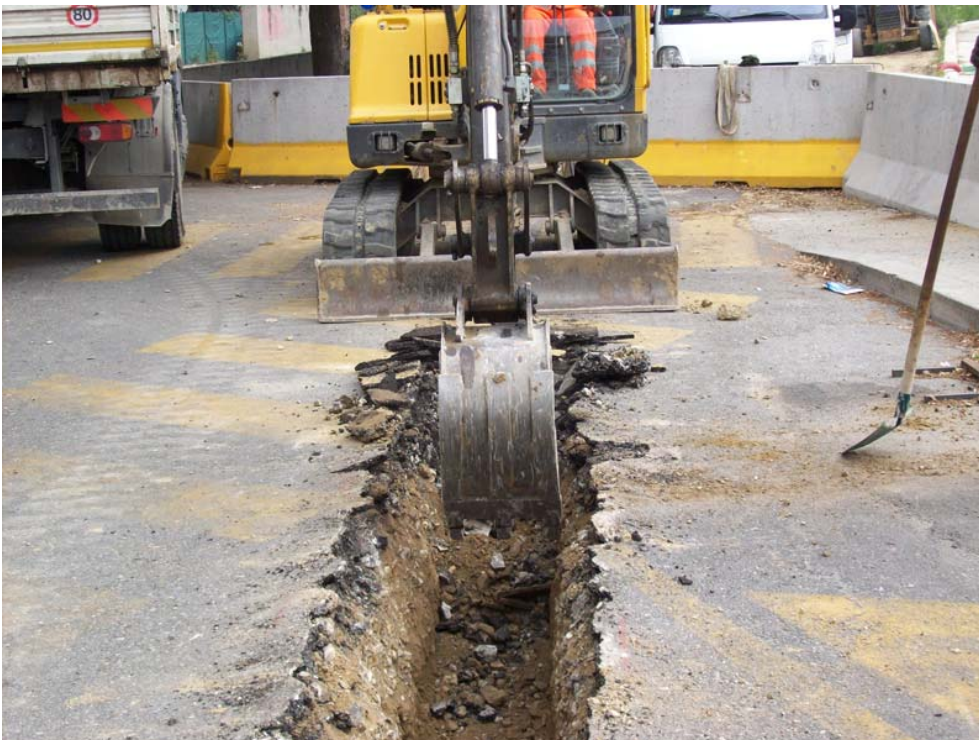
Esempio di trincea
