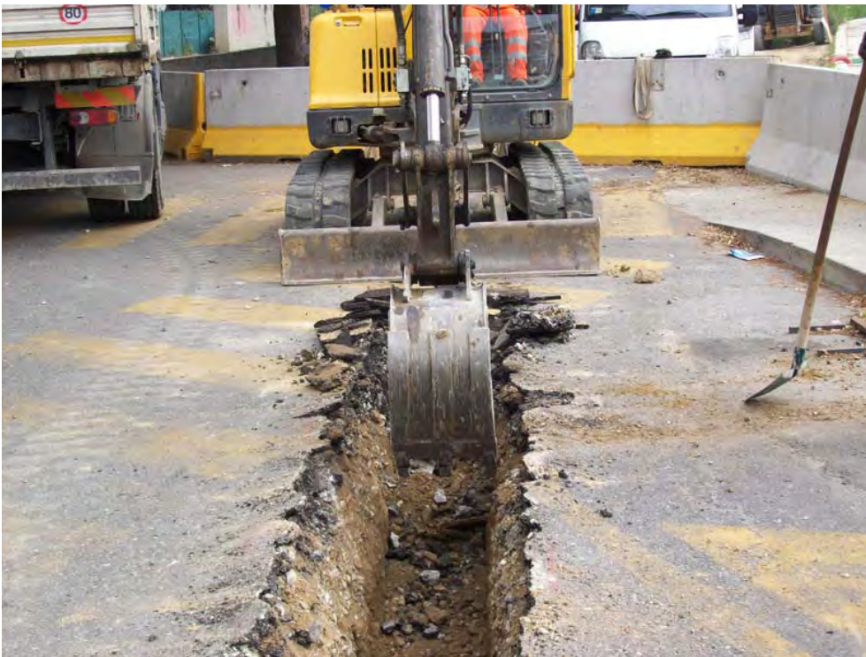
Esempio di trincea
