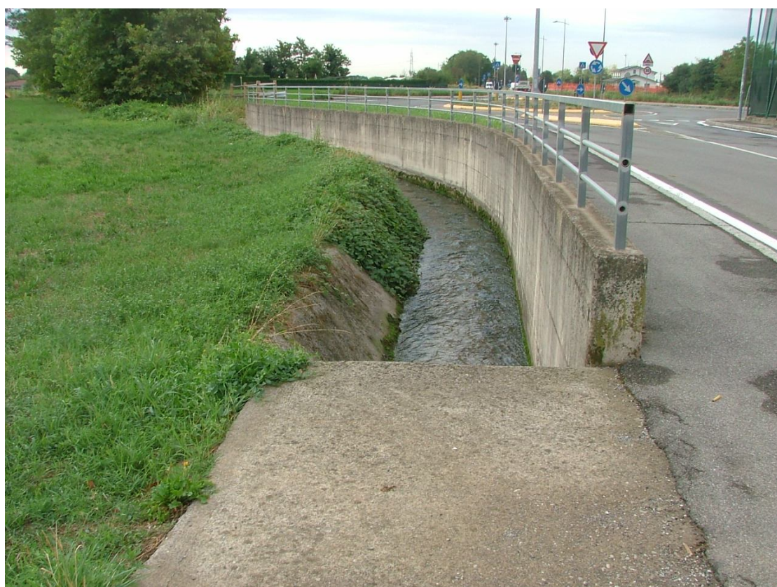
CONO OTTICO N.2: VISTA DA NORD VERSO SUD DELLA ROGGIA MORLINO DAL PONTICELLO IN C.A. ESISTENTE FRONTE VIA BASELLA
