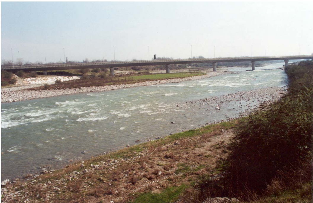
Foto 2 – Ponte della S.S. n° 342
